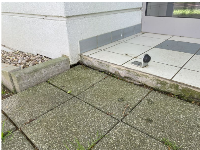
Photographies des décrochements observés au sein des autres bâtiments et ouvrages alentours
