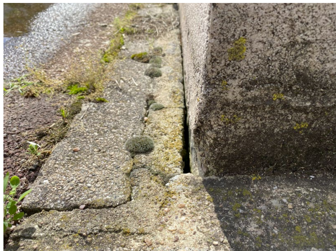
Photographies des décrochements observés au sein des autres murs du restaurant universitaire
