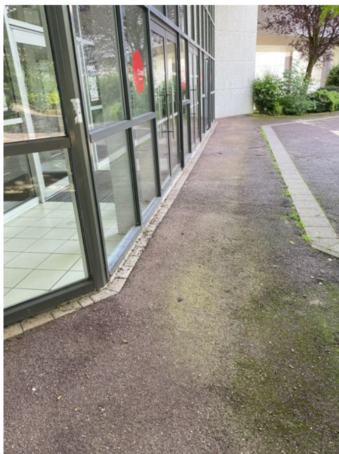
Photographies du sas d'entrée et des enrobés encaissants présentant un léger bombement
