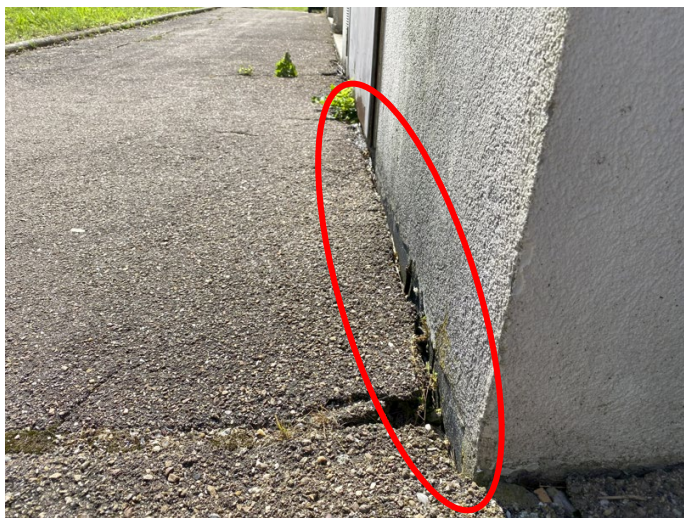
Photographies des décrochements observés au sein des autres murs du restaurant universitaire
