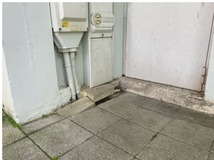
Photographies des décrochements observés au sein des autres bâtiments et ouvrages alentours
